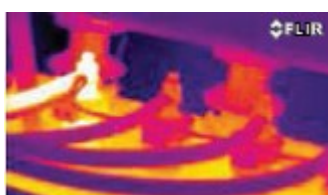
FLIR thermal image
