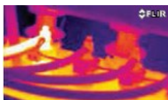
FLIR thermal image
